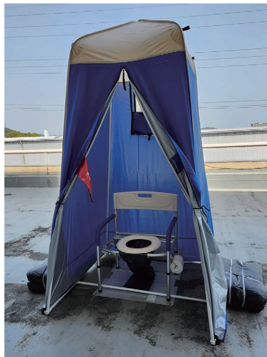
マンホールトイレ
