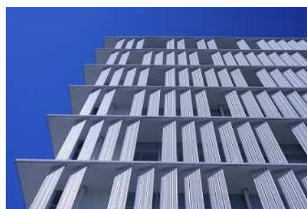
庇とルーバーで 日射を抑制した事例（飯塚市役所）
