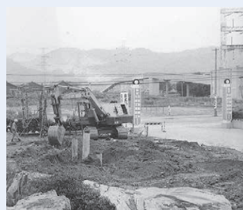
歴史資料館建設工事中
