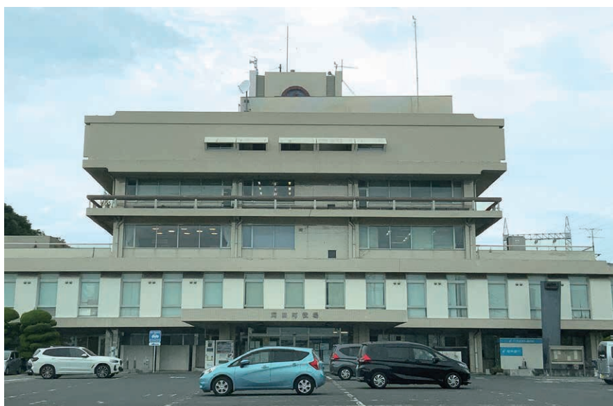
老朽化が進む役場本庁舎
