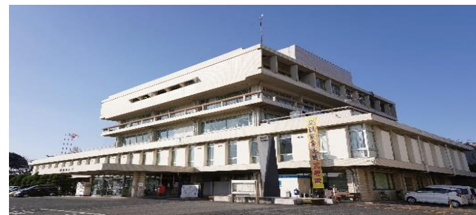
荻田町役場新庁舎建設
