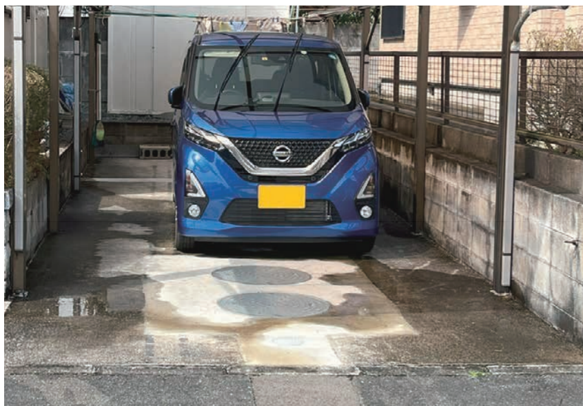
車庫内に設置した浄化槽
