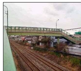
桜ヶ丘歩道橋
