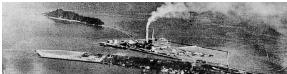
1959(昭和34)年当時の九州電力(株)苅田発電所
