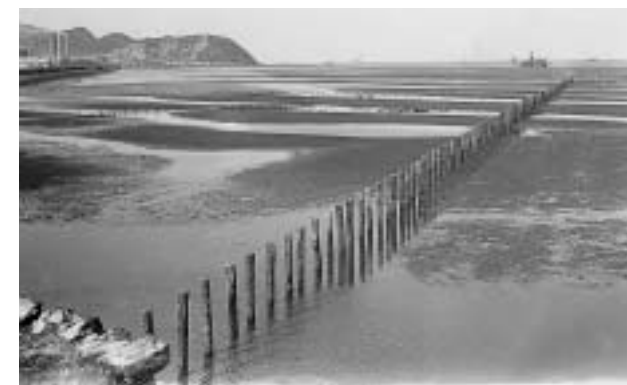
苅田港築港のための護岸工事1937(昭和12)年撮影 (写真提供 - 松田恵氏)
