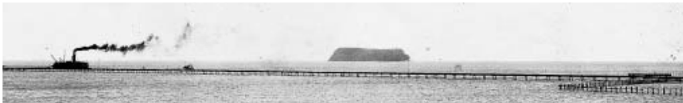
ポンプ浚渫土の運搬風景 1939(昭和14)年頃撮影(写真提供 - 松田恵氏)
