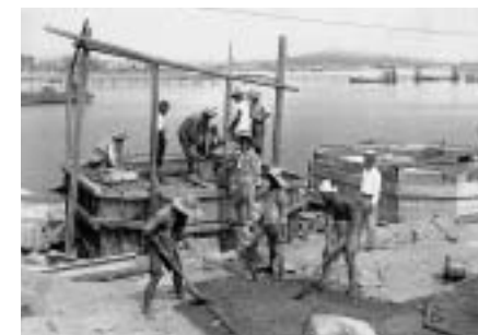
苅田港築港のための護岸工事1937(昭和12)年撮影 (写真提供 - 松田恵氏)
