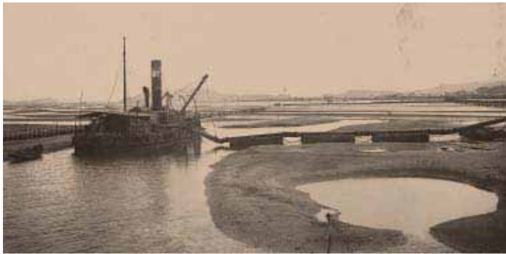
1939（昭和14）年頃ポンプ浚渫船「東谷丸」による埋立（苅田港より南方を望む） 船の後方二先山、右井場川尻（写真提供 - 松田恵氏）
