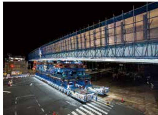
5月30日に開通した苅田若久高架橋
