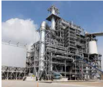
竣工したバイオマス発電所
