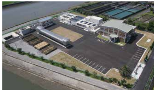
▲苅田町の水道水の約 70%を作っている二崎浄水場
