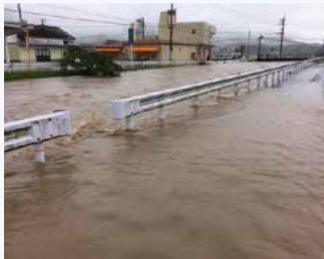
↑平成30年7月豪雨では町内の一部が冠水
