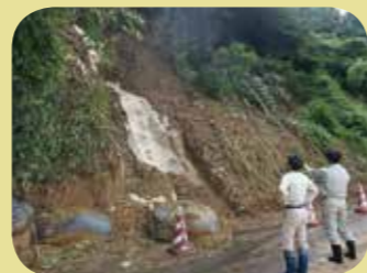
豪雨により発生した土砂崩れの現場を確認する職員
