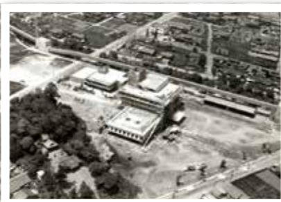
▲建設中の役場庁舎
