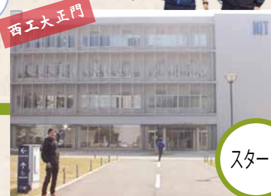
西工大正門 平成 24 年 12 月に新館が完成
