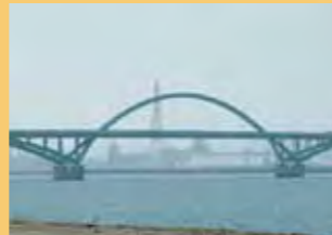
北九州空港連絡橋
