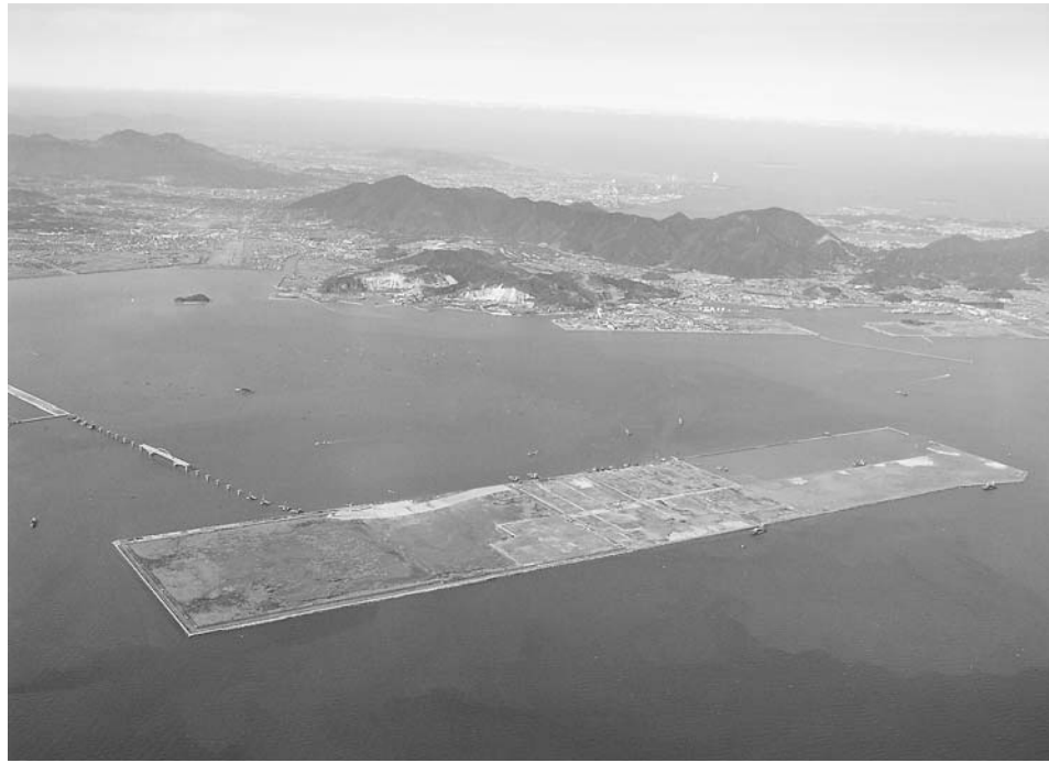
▲平成17年の開港へ向けて建設が進む新北九州空港
