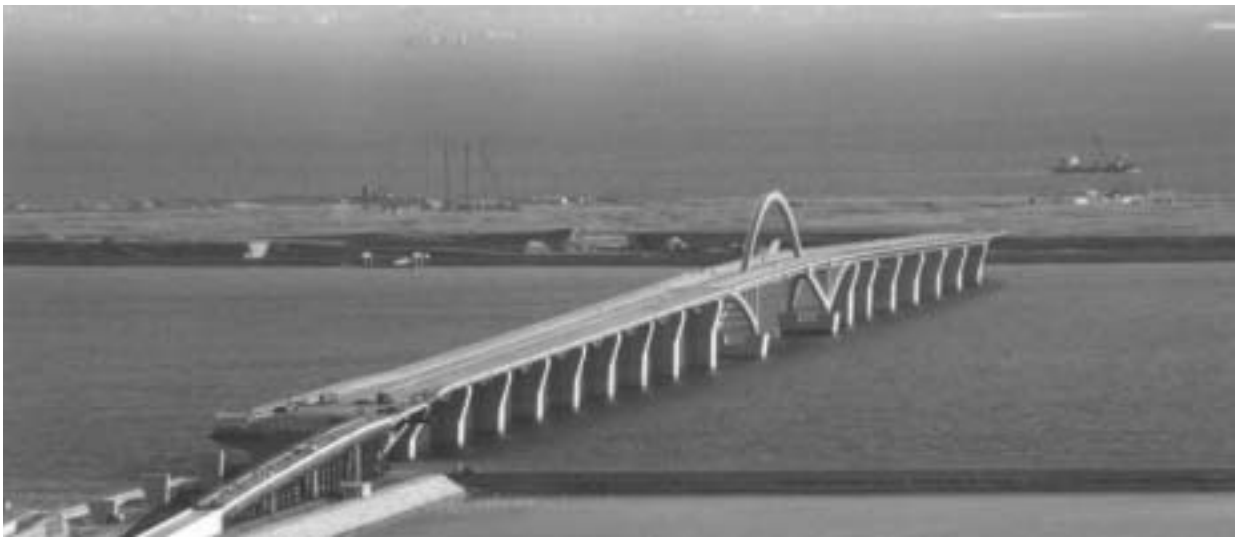
建設が進む、新北九州空港と連絡橋
