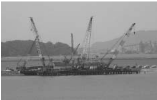
化学弾処理関連の工事
