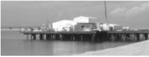
(建設中の化学弾無害化処理施設)
