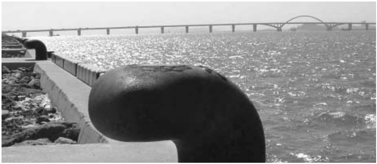
建設が進む、新北九州空港と連絡橋
