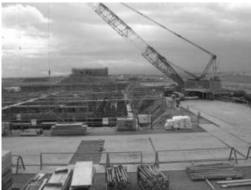
建設が進む新北九州空港
