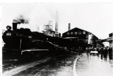
セメント出荷専用SL 昭和46年
