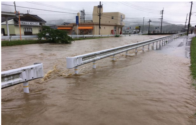
近年、苅田町でも自然災害が発生（平成30年7月豪雨）
