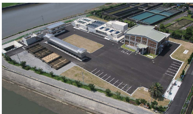
▲苧田町の水道水の約 70%を作っている二崎浄水場
