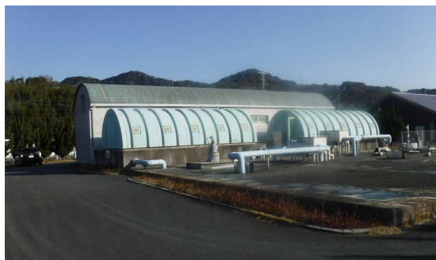
▲家庭から出る汚れた水をきれいにする片島処理場
