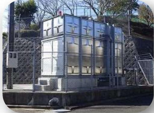
高架水槽方式から加圧ポンプ方式に変更した受水槽及びポンプ室
