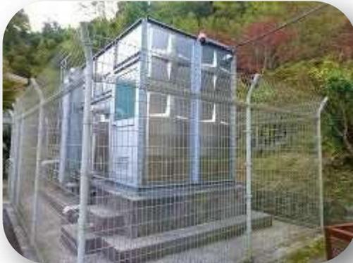
土砂災害により地上式へ切り替えた受水槽
