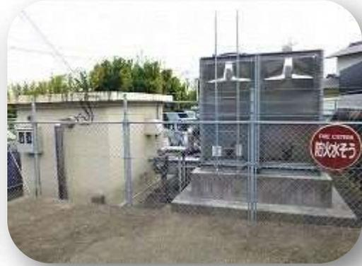
ステンレス製に変更した受水槽
