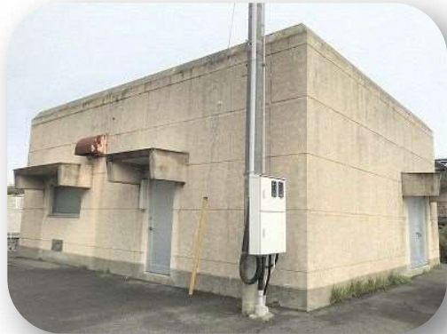
<尾倉加圧ポンプ室>
