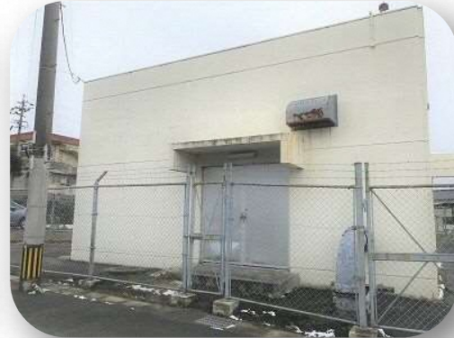
<片島加圧ポンプ室>
