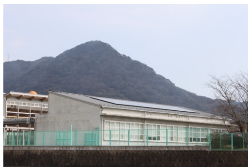
白川小学校校舎に設置されている 太陽光発電施設
