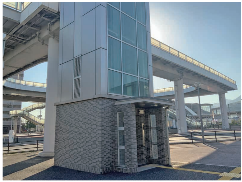
苅田駅ロータリーのエレベーター
