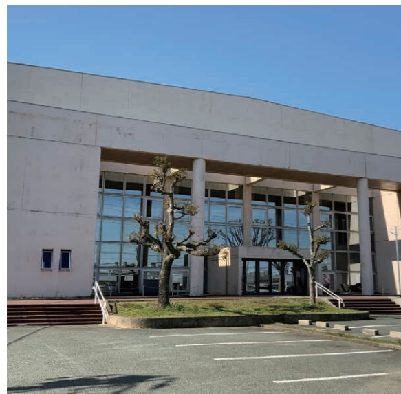
苅田町総合体育館
