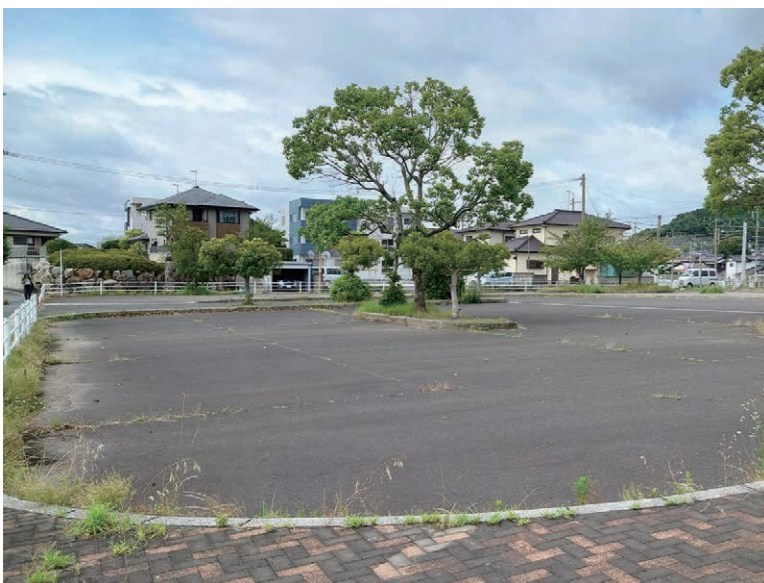
小波瀬西工大前駅広場
