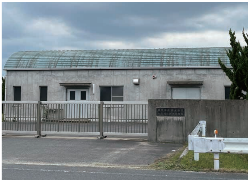
農業集落排水処理場
