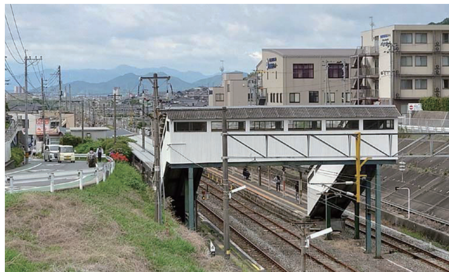
小波瀬西工大前駅周辺
