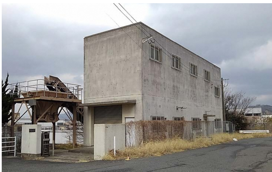
ポンプ場 (幸町)
