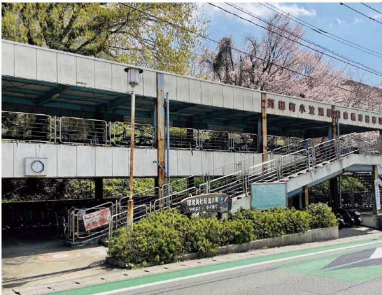
解体予定の小波瀬西工大前自転車駐輪場
