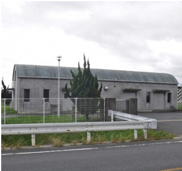
片島地区汚水処理場
