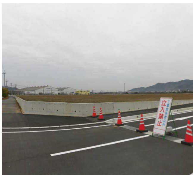
南原・殿川町地区開発地
