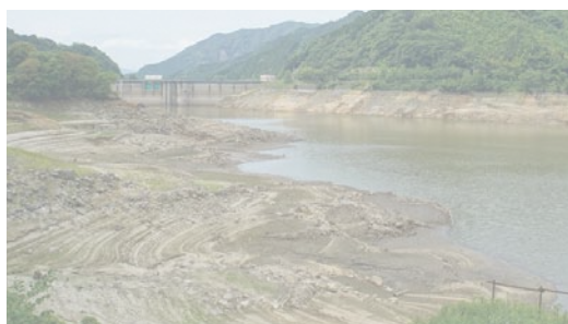
水位が低下した油木ダム
