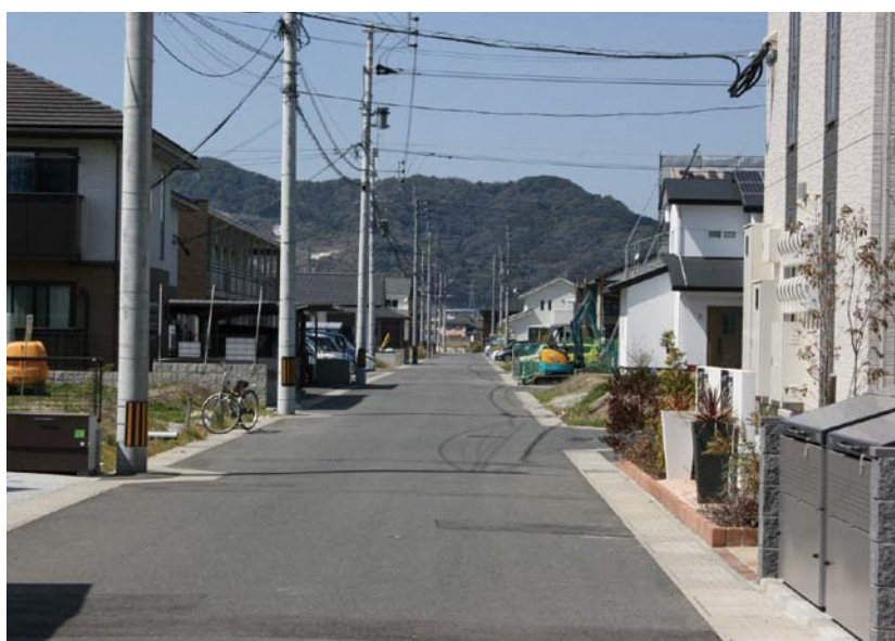
与原土地区画整理事業 1工区の外灯がない町道
