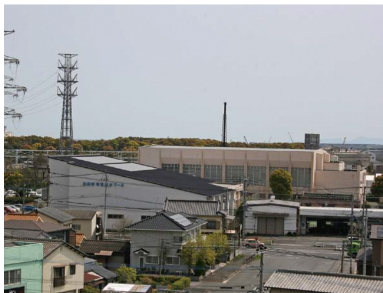
町民温水プールと体育館
