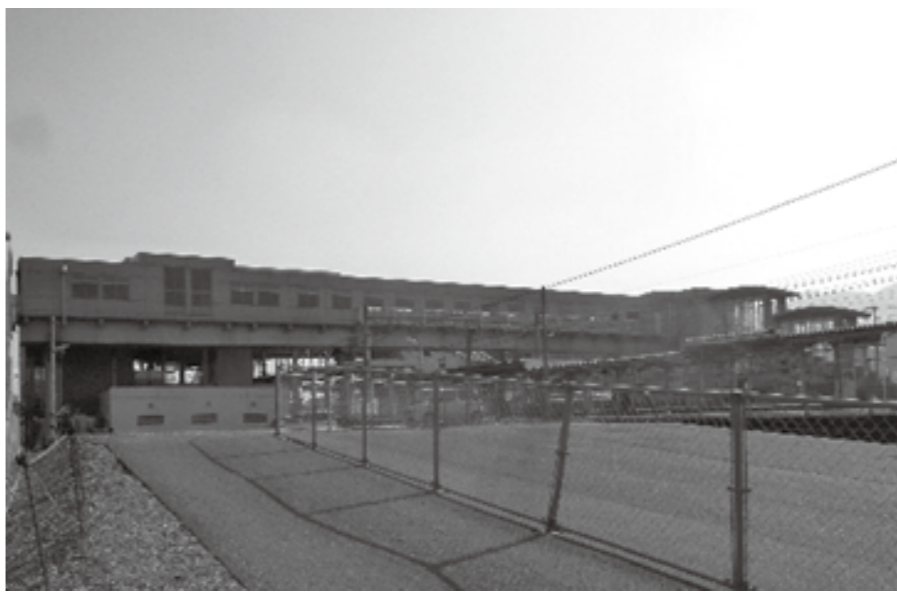
苅田駅東西線通路橋
