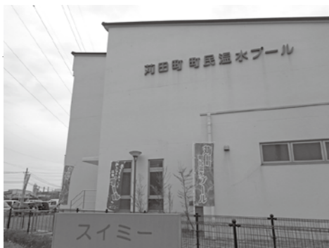
町民温水プール
