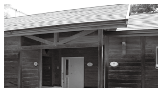
パンジープラザ屋外の多目的トイレ
