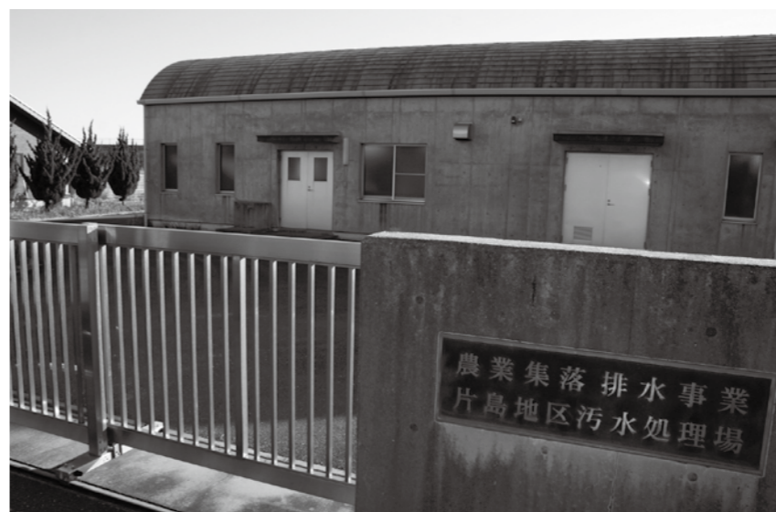
片島・白川南部地区の農業集落排水処理施設
