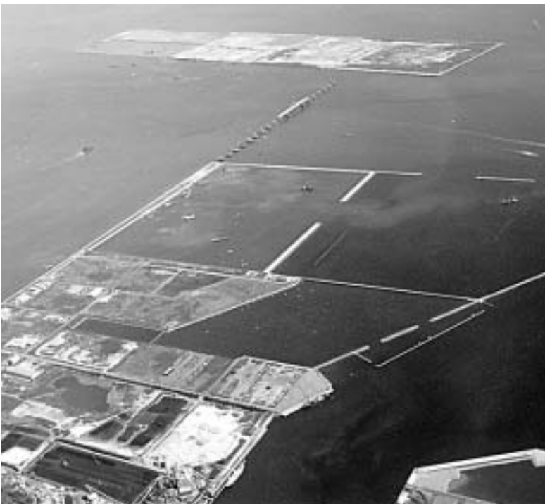
工事が順調に進む空港島
