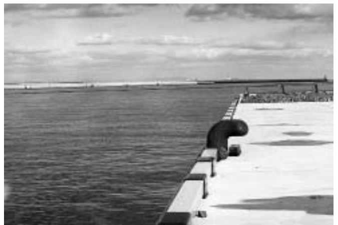
爆弾処理が待たれる工事現場
