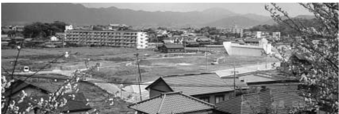
空港連絡道路建設風景
