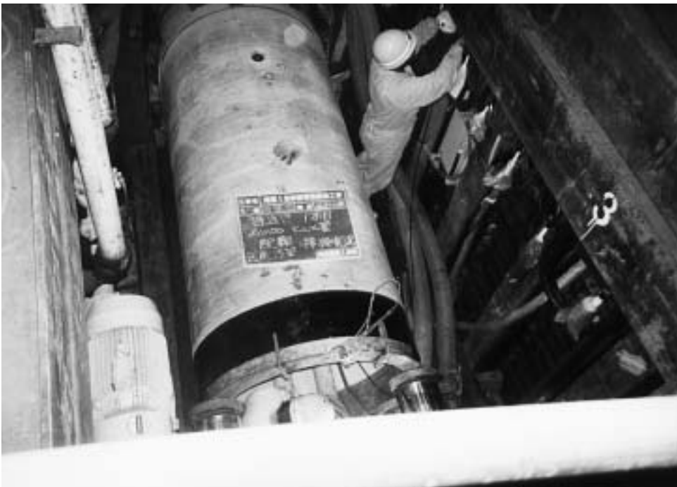
下水道完成をめざす推進工事
