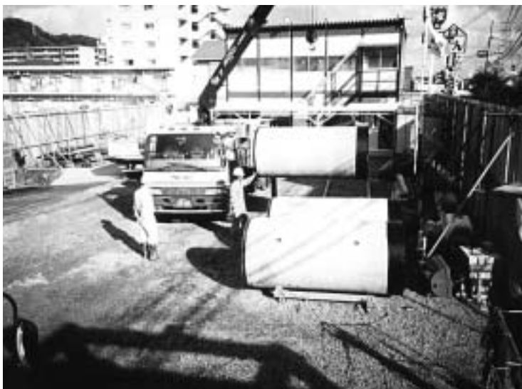
下水道推進工事
