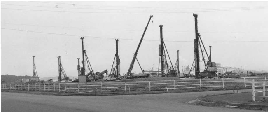
急ピッチに進む工場建設
