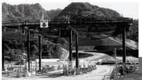
建設中の「町田北九州空港」料金所
