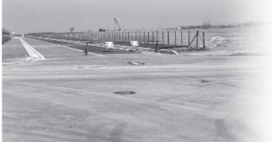
一部分工が開始された臨空産業団地
