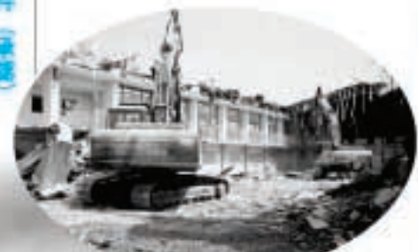
解体中の菊田小学校体育館
