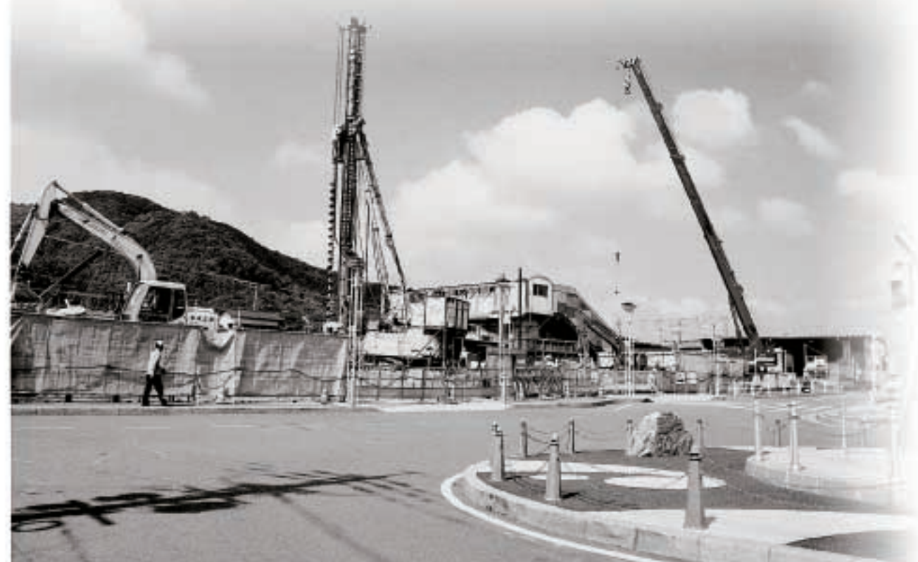
東側と西側を繋ぐ自由通路工事が進むJR菊田駅
