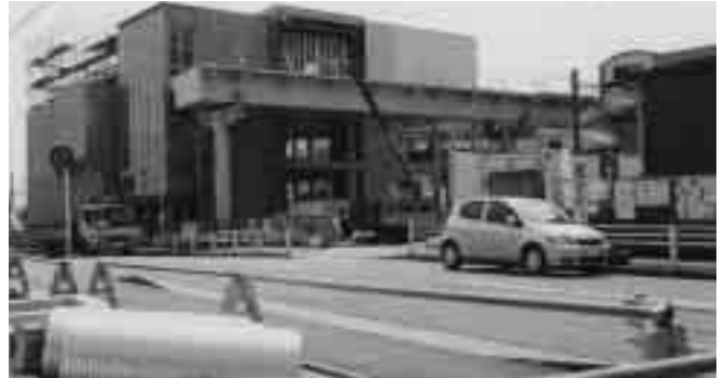
荻田駅舎東西自由通路
